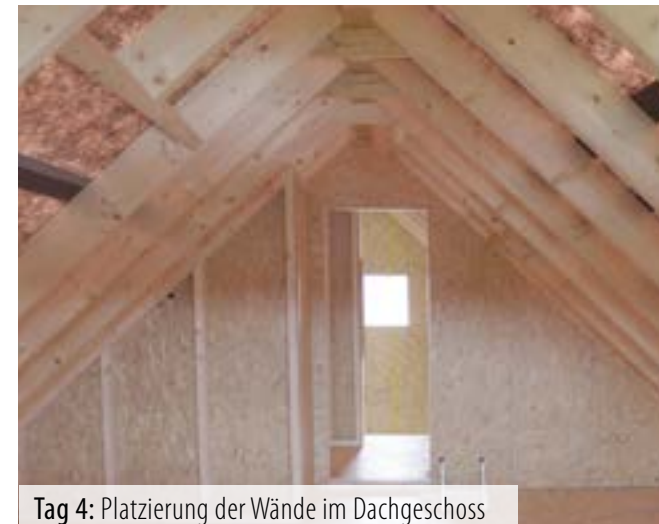
Positionierung der Mittelpfetten
