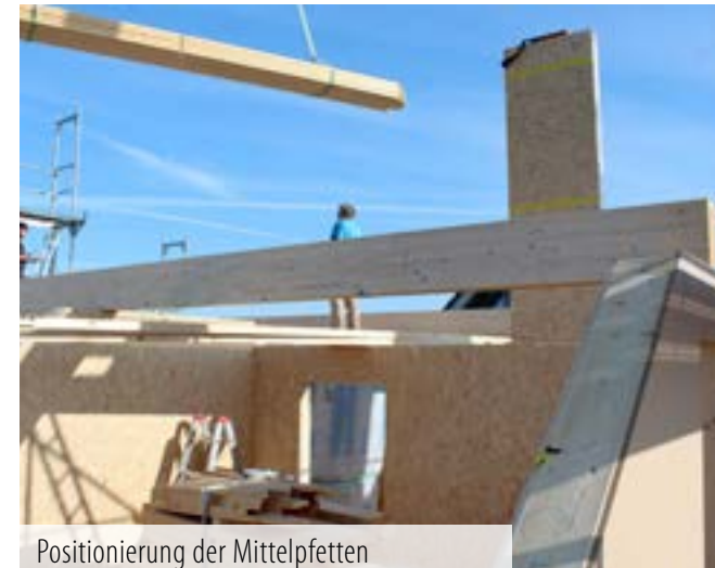
Ersten Wandelemente des Obergeschosses
