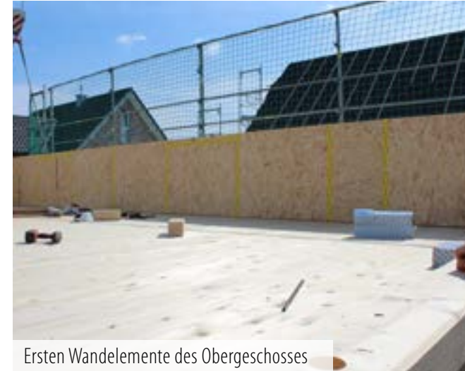
Tag 3: Alle Wandelemente des Obergeschosses
